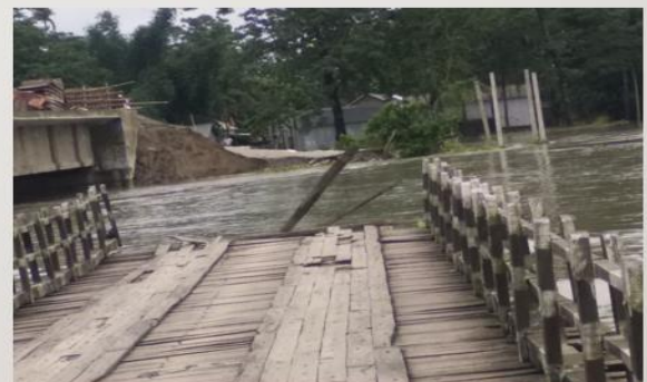
Kandapara-Rupakuch bridge, Barpeta
